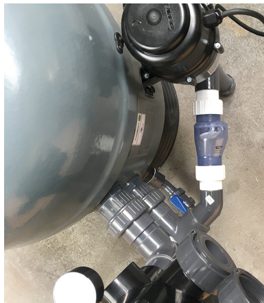
ABB. 4: Darstellung des Anschlusses des Druckübersetzer an die Filterversorgung (achten Sie darauf, dass das Rückschlagventil in der richtigen Richtung installiert ist).
