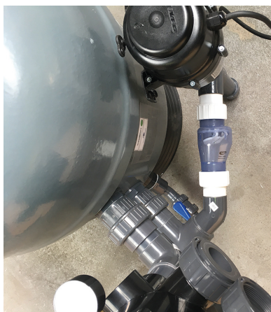
FIG. 4 : Représentation de la connexion du surpresseur à l'alimentation du filtre (veillez à installer le clapet anti-retour dans le bon sens)
