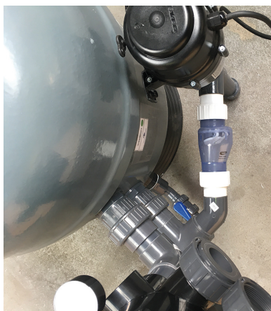
FIG. 4 : Afbeelding van de aansluiting van de opvoerpomp op de filtertoevoer (let erop dat de terugslagklep in de juiste richting is gemonteerd).
